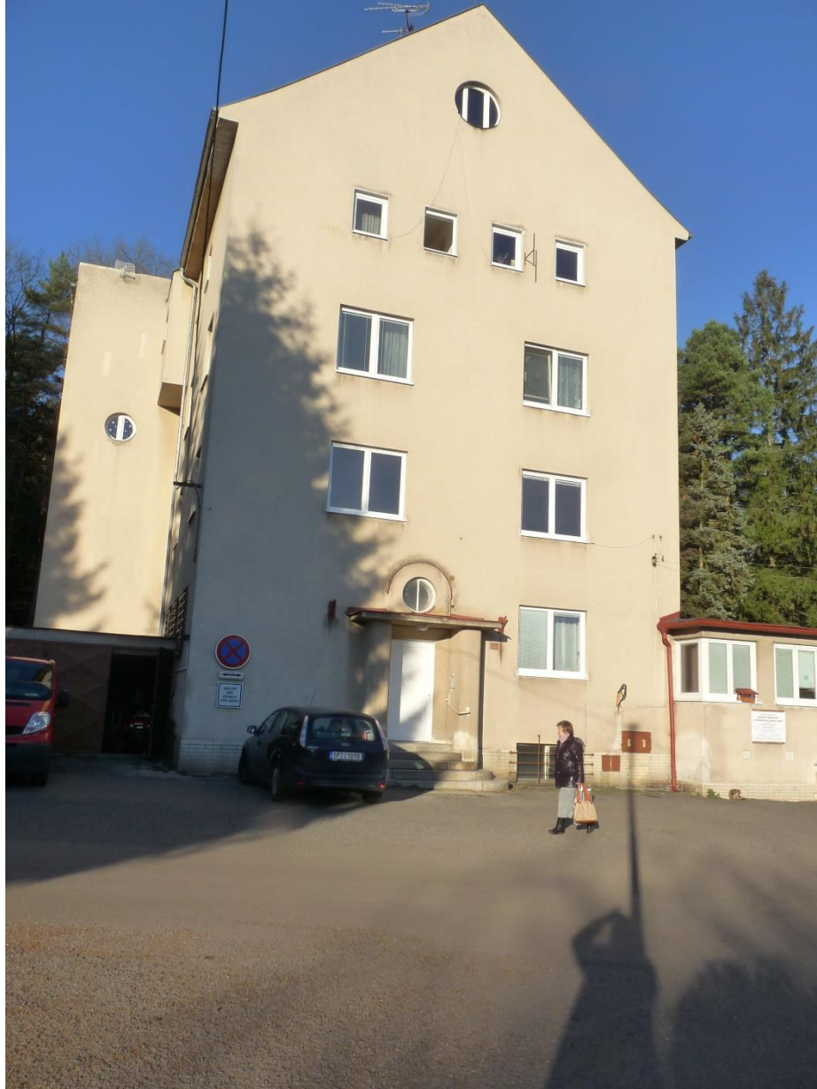
Obr. 5. Správní budova janovského sanatoria dle projektu H. Zápala. Foto autor, 2015.
